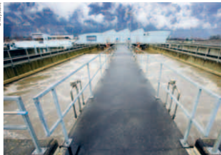
Les centrales d'épuration produisent du biogaz utilisable pour les moteurs.
